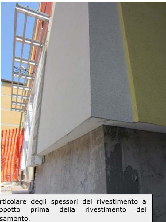
Particolare degli spessori del rivestimento a cappotto prima della rivestimento del basamento.
