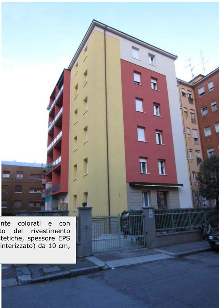
I settori diversamente colorati e con spessore differenziato del rivestimento hanno solo finalità estetiche, spessore EPS (polistirene espanso sinterizzato) da 10 cm, 13 cm e 16 cm.
